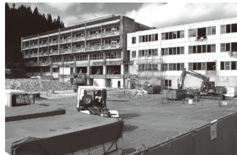
解体撤去後の活用方策が問われる (解体工事中の旧公立小野町地方総合病院)
