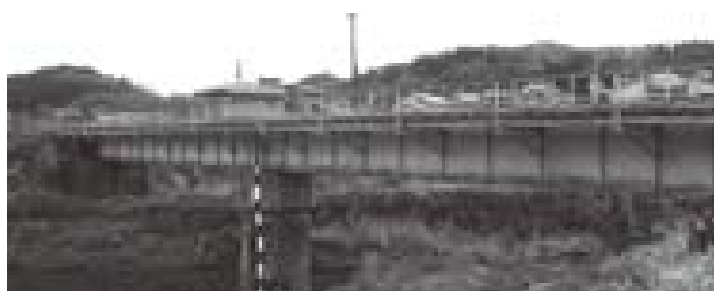
右支夏井川河川改修に伴い架け替えとなる鉄道橋（谷津作）
