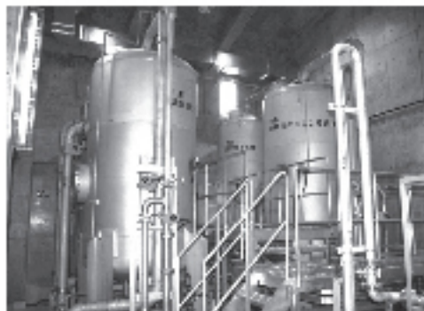
こまち浄水場内部のようす
