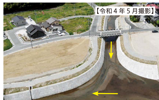
写真2－車川合流付近の竣工状況
