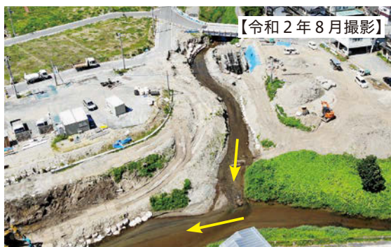
写真1－車川合流付近の施工中状況
