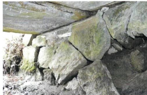
橋台石積の崩落、ずれ
