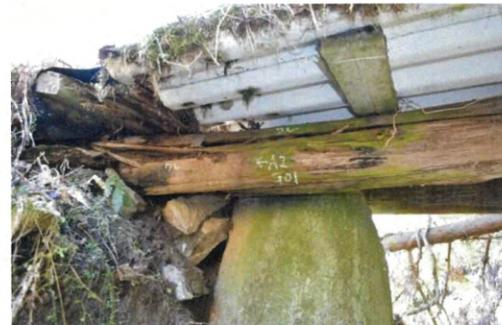
桁端部の木部材の腐朽
