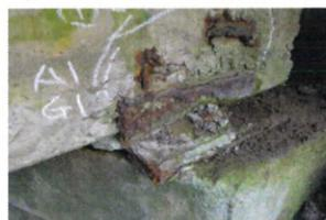
主桁の鉄筋露出(Ⅱ)、支承の腐食(Ⅲ)
