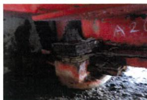
主桁の腐食(Ⅱ)、支承の腐食(Ⅲ)
