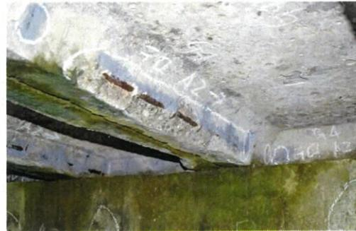
主桁の鉄筋露出
