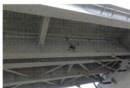
ドローンによる桁下の点検
