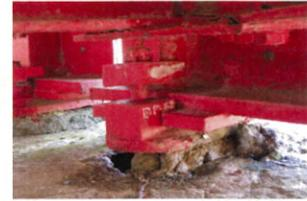
支承の沓座モルタル欠損、ボルトゆるみ(Ⅲ)
